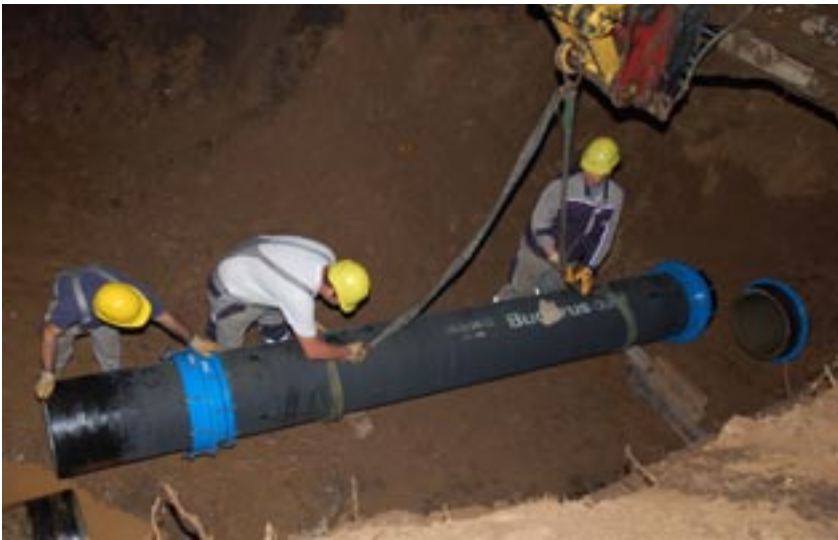
Rohrtausch gegen Mitternacht
