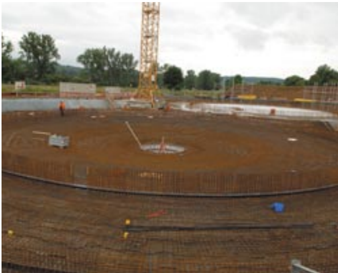
Ein Fundament aus Stahl
